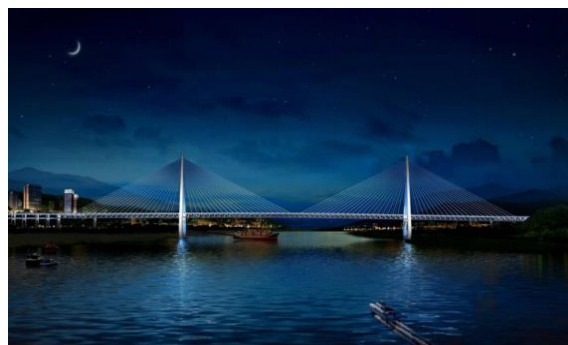
重庆白居寺长江大桥景观灯饰工程
