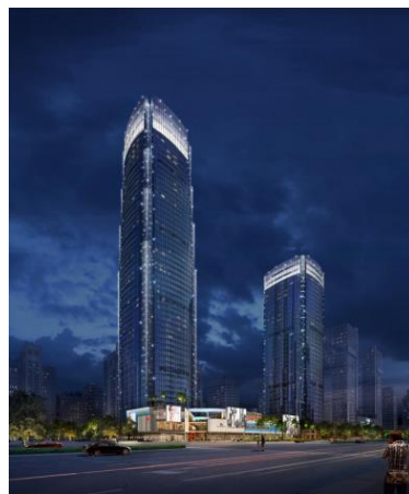
海航中心D10项目泛光照明设计项目
