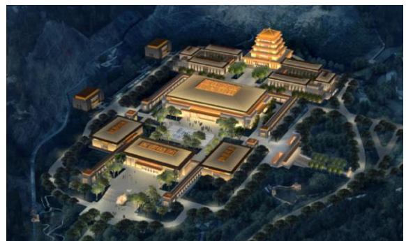
二二工程景观照明和泛光照明工程
