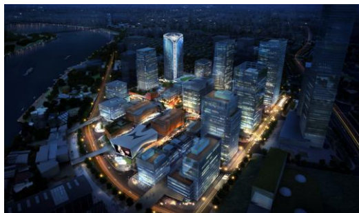
徐汇滨江188S-G-1地块新建项目泛光照明工程 设计与施工工程
