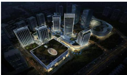
重庆金科照母山项目 B5-1/05 地块泛光照明工程 二标段
