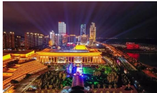
厦门国际会展中心四期项目景观照明工程
