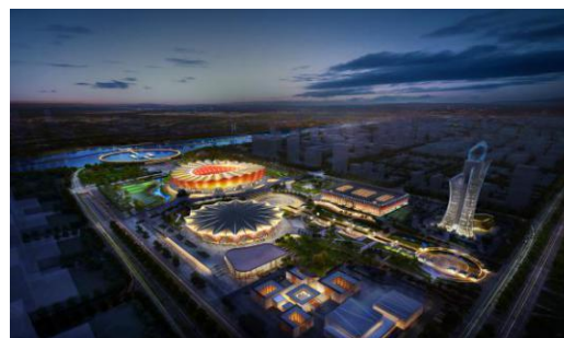
西安奥体中心项目体育场泛光照明工程 一期泛光照明工程
