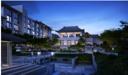
北京环球影城主题公园配套建设（一期）项目 泛光照明工程
