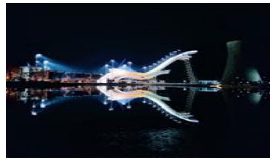
首钢滑雪大跳台中心设备安装工程
